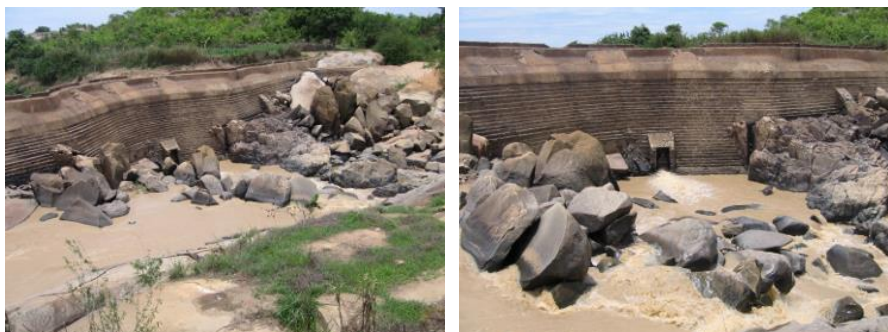
Ilustração 9: Exemplo de minibarragem em bom estado
