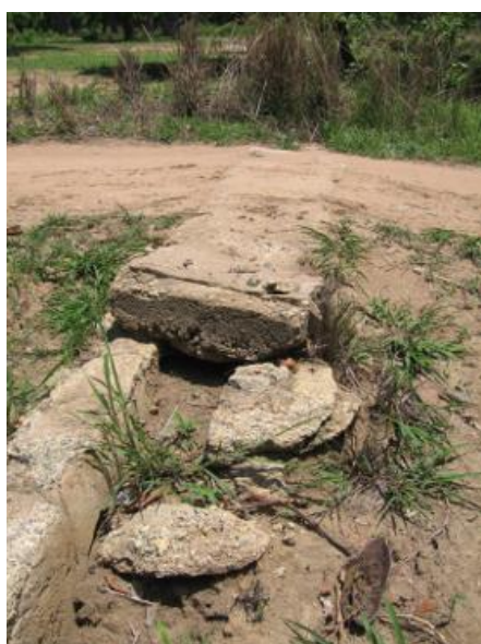
Ilustração 11: Poços, válvulas hidráulicas e canais de irrigação
